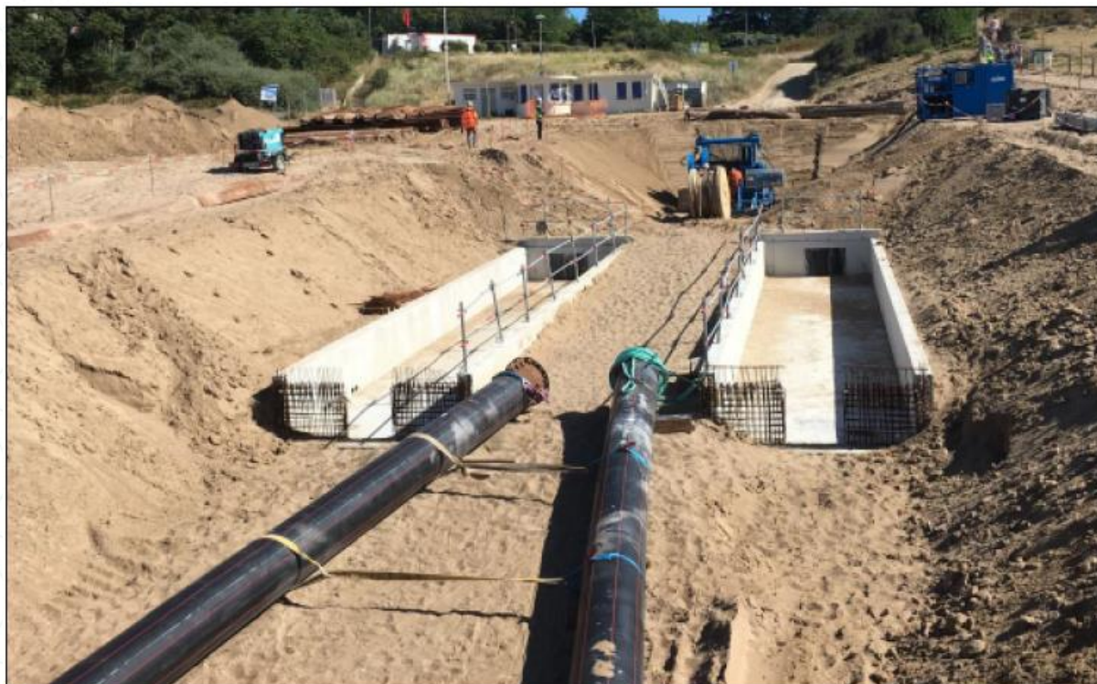
Figure 12 : Deux chambres d'atterrage – avant positionnement des fourreaux (RTE - projet de raccordement électrique du parc éolien de Saint-Nazaire)
