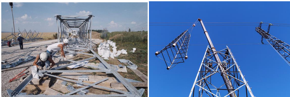
Figure 22 : Assemblage (gauche) et levage (droite) d'un pylône treillis
