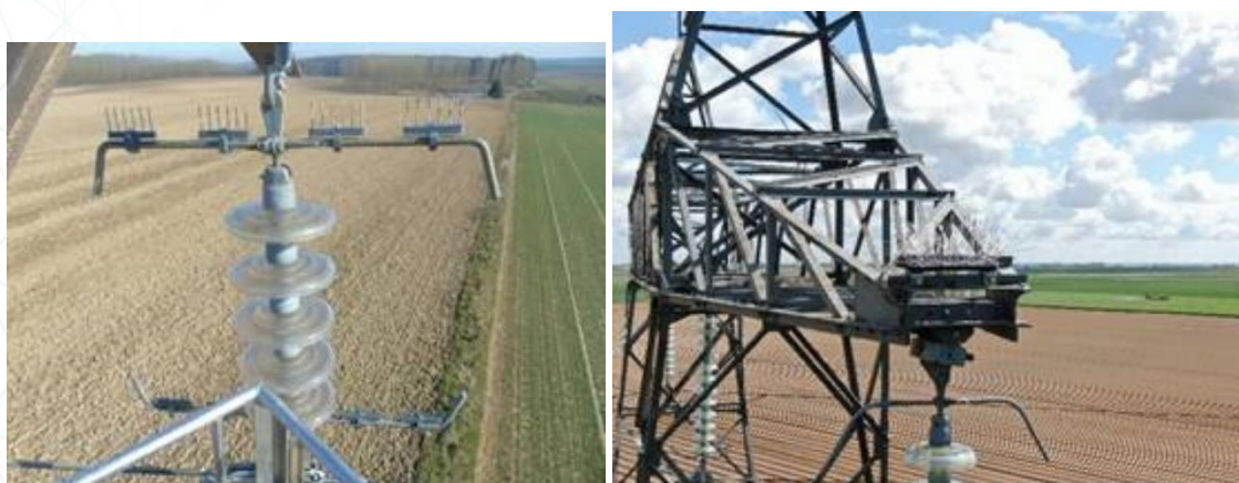
Figure 14 : Exemples de pics avifaune (source RTE)
