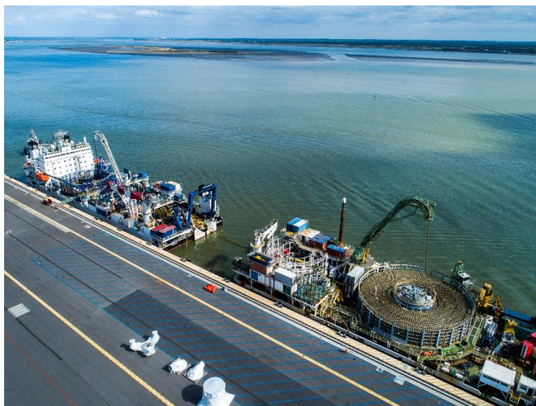
Figure 19 : Exemple d'opération de transfert de câble du navire de transport vers un navire câblé (photo RTE du chantier de Saint-Nazaire)
