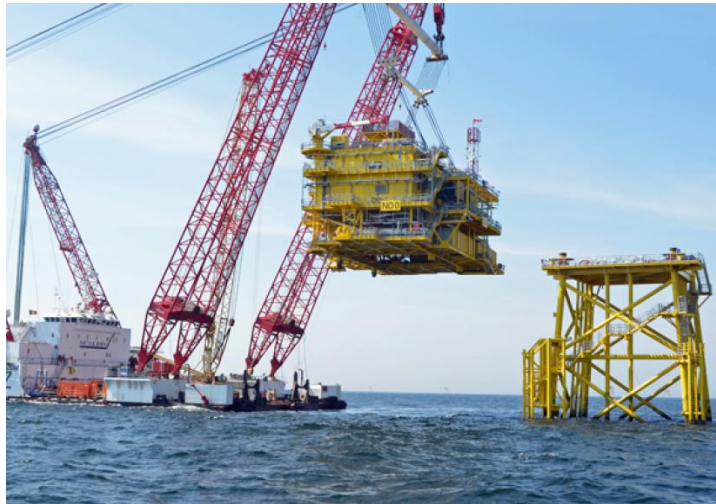
Figure 18 : Exemple d'installation d'un topside
