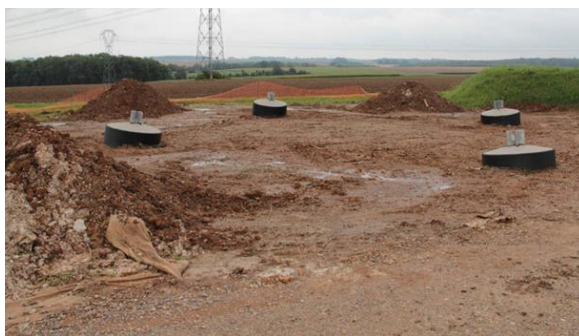
Figure 21 : Fondations d'un pylône treillis
