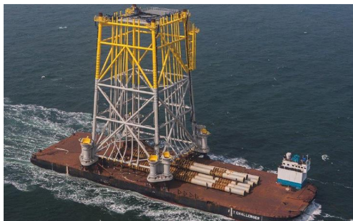
Figure 16 : Exemple de transports de pieux et de la sous-structure sur une barge
